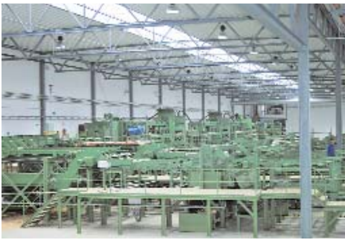
Blick auf die Linie – neu errichtete Halle mit Tageslichteinfall sorgt für ein angenehmes Arbeitsklima
