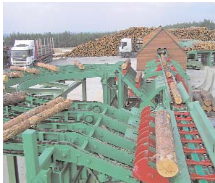
Rundholzaufgabe mit Vermessung und Kurvenwender bei der Sortieranlage
