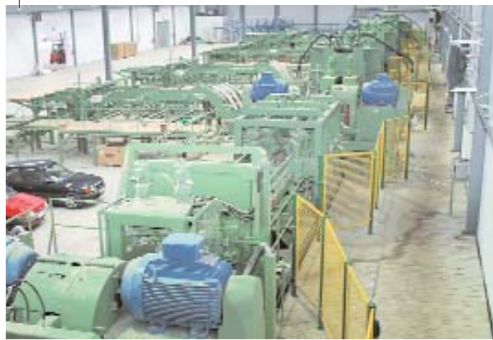
Profilier-Spaner-Kreissägeanlage während der Inbetriebnahme-phase
