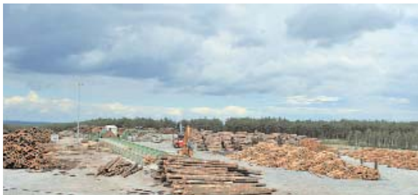
Rundholzplatz mit der neu installierten SAB-Sortieranlage mit 36 Boxen
